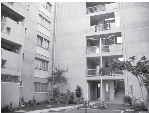
Figura 8. Construcción de vivienda social en Santiago de Chile
