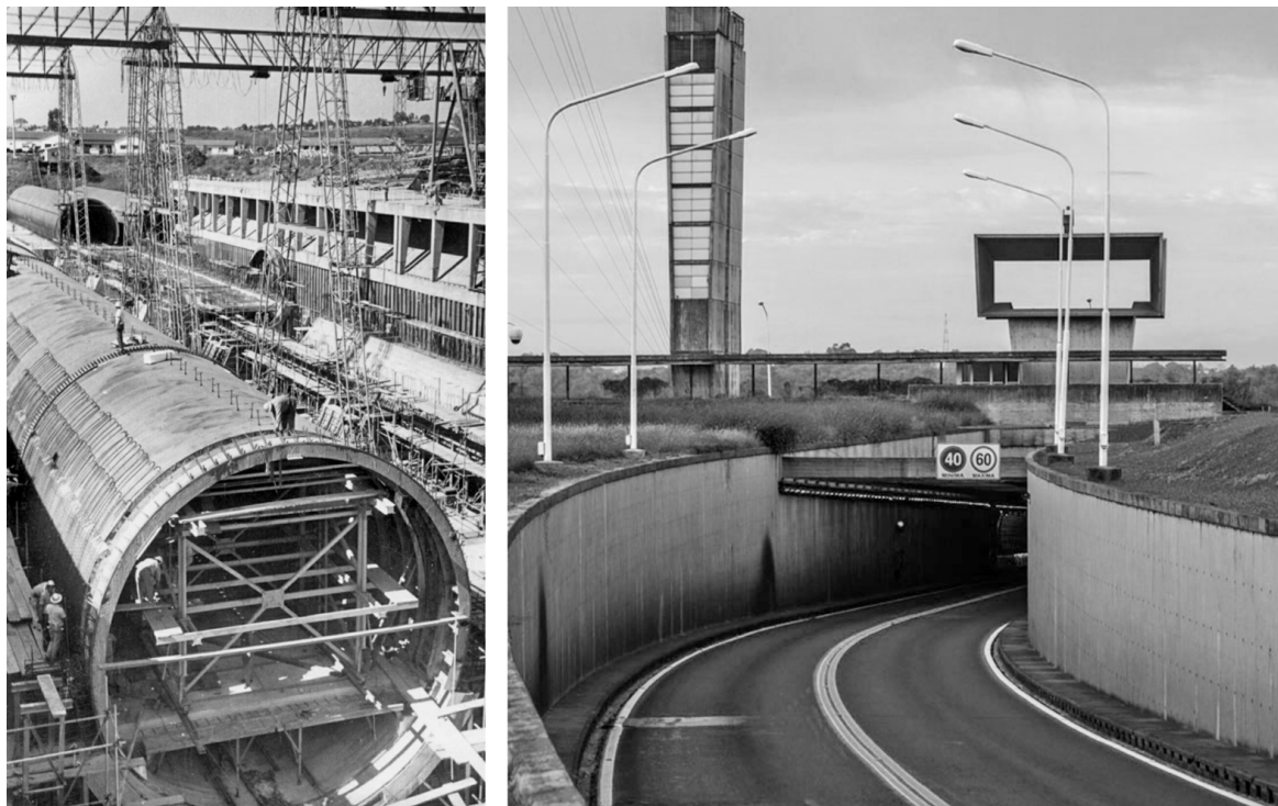
Figura 3. Túnel Subfluvial Raúl Uranga-Carlos Sylvestre Bagnis. Izquierda, construcción de los tubos en dique seco; derecha, vista de la rampa de acceso al túnel. Fuente: ENTE INTERPROVINCIAL TÚNEL SUBFLUVIAL (s/f)
