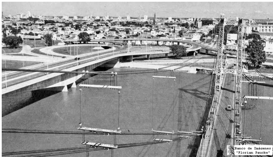
Figura 6. Vista aérea de ambos puentes sobre la laguna Setúbal, 1975; puente y viaducto Nicasio Oroño (izq.), antiguo puente colgante (der.). Fuente: banco de imágenes Florián Paucke
